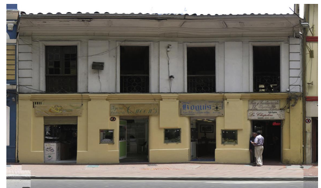
Fuente: Equipo Fotografía PEMP Patrimonio Inmueble
